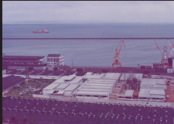
Figura 13 – Construção do novo Hospital Naval de Salvador – área portuária de Salvador
