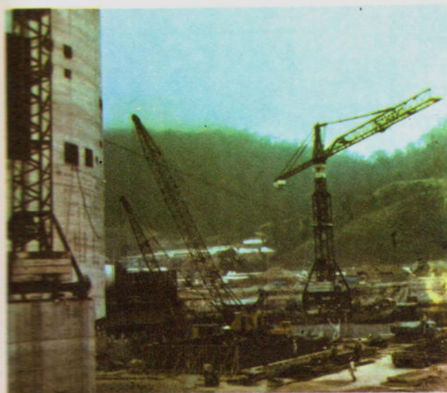
Obras do reator
