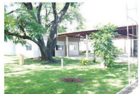
Nova sede em obras
