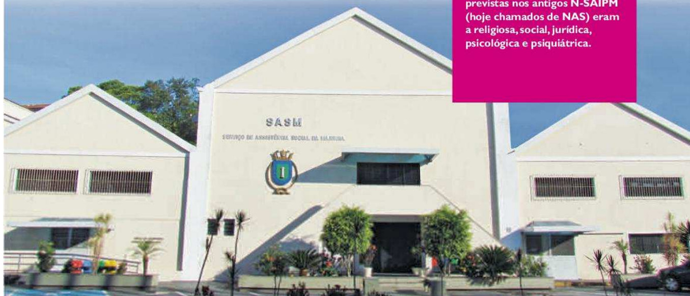
Nova fachada do prédio do SASM
