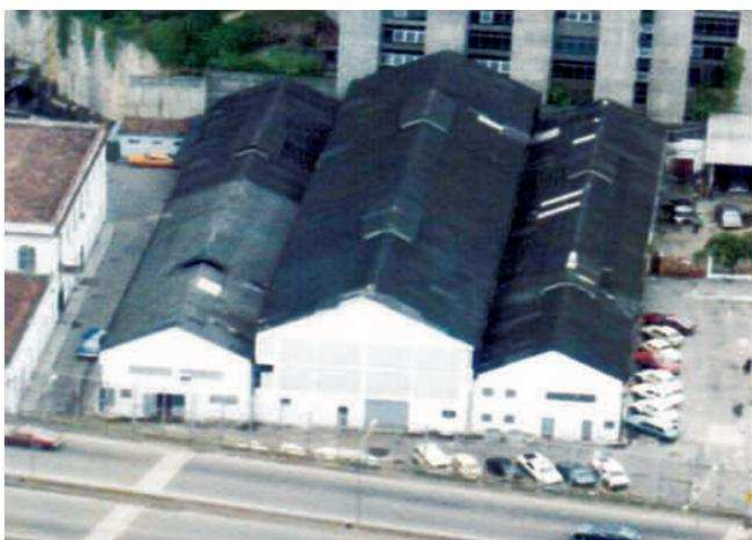
Antigas instalações do SASM
