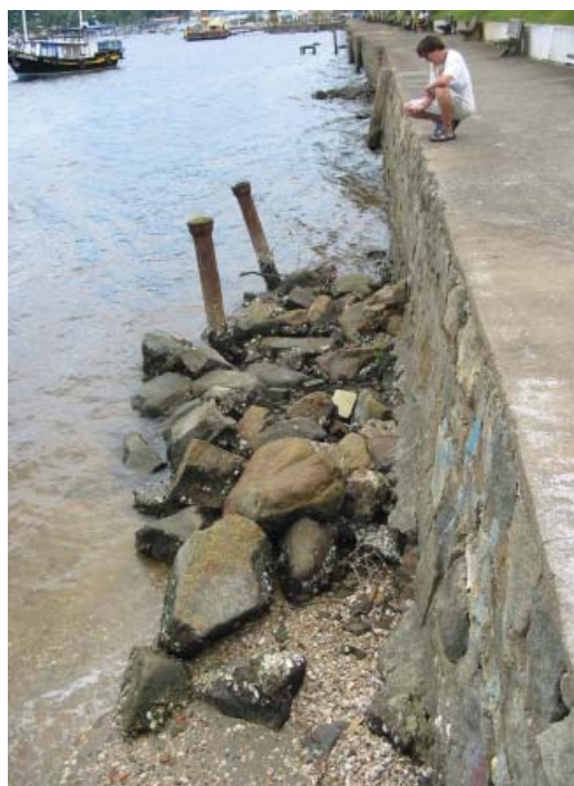
ZPC, restos do píer da Fábrica de Barris (foto do autor, 2007)
