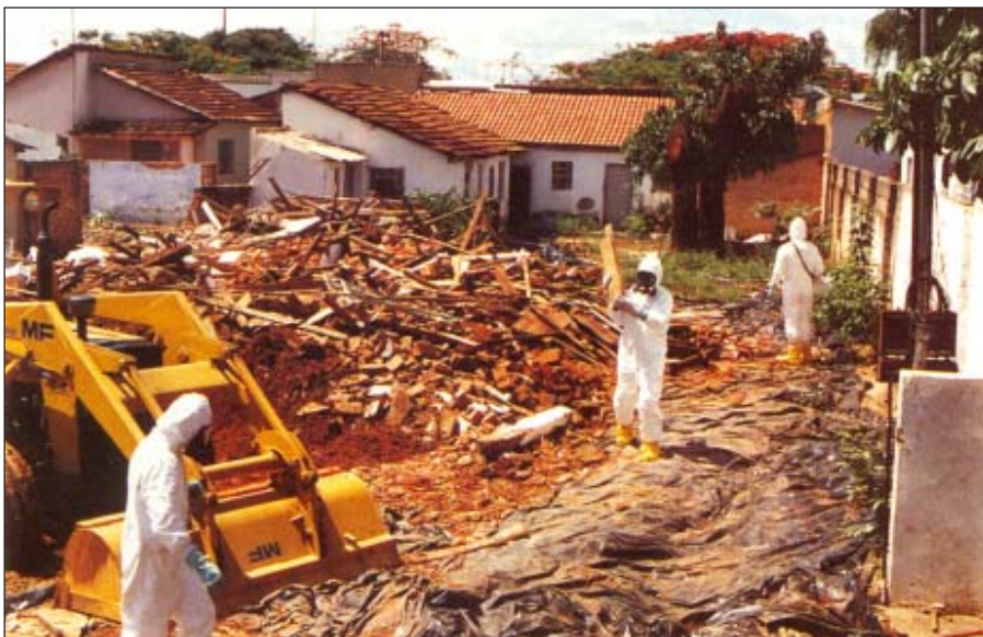
Demolição das casas das vítimas
