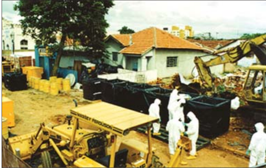
Trabalhadores devidamente protegidos em local contaminado
