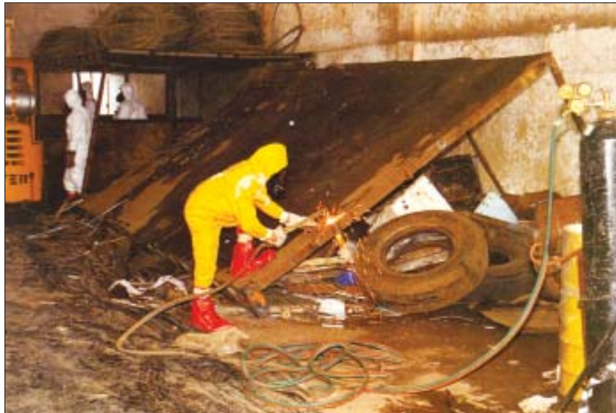
Demolição do ferro-velho onde ocorreu o vazamento do Césio 137
