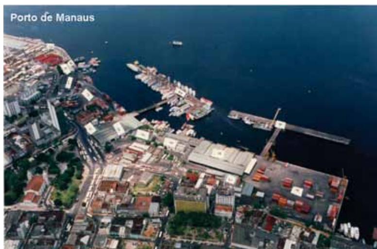
Vista aérea do Conjunto do Porto
