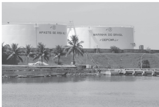
Parque de Tancagem do DepCMRJ
