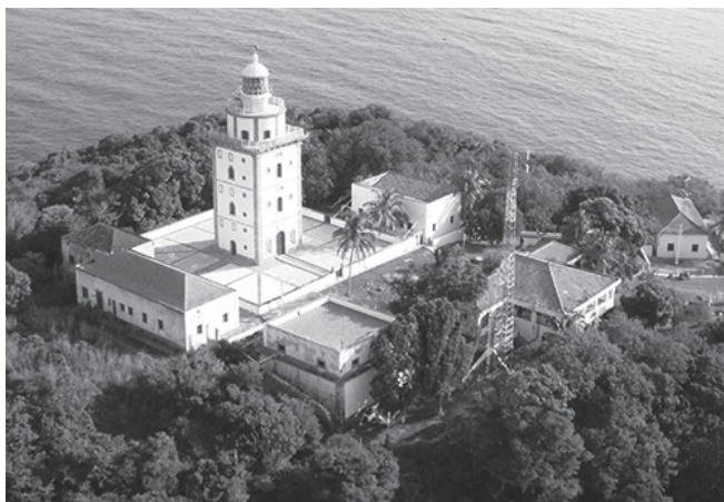
Vista panorâmica da Ilha Rasa
