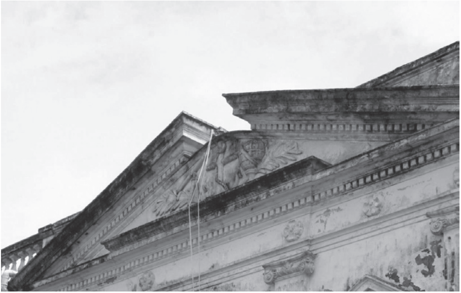
Imagem 7 – Vista do frontão da edificação durante obras de recuperação em 2011 Foto: Ricardo Guimarães
