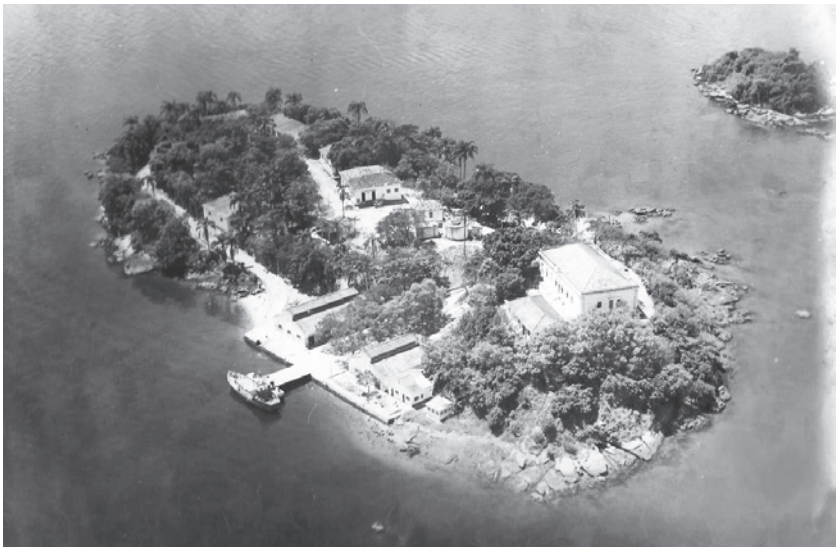
Imagem 4 – Na imagem com vista aérea da Ilha do Rijo, possivelmente de meados do século XX, pode-se observar as diversas benfeitorias da Ilha. Fonte: Livro do Estabelecimento do Centro de Munição da Marinha
