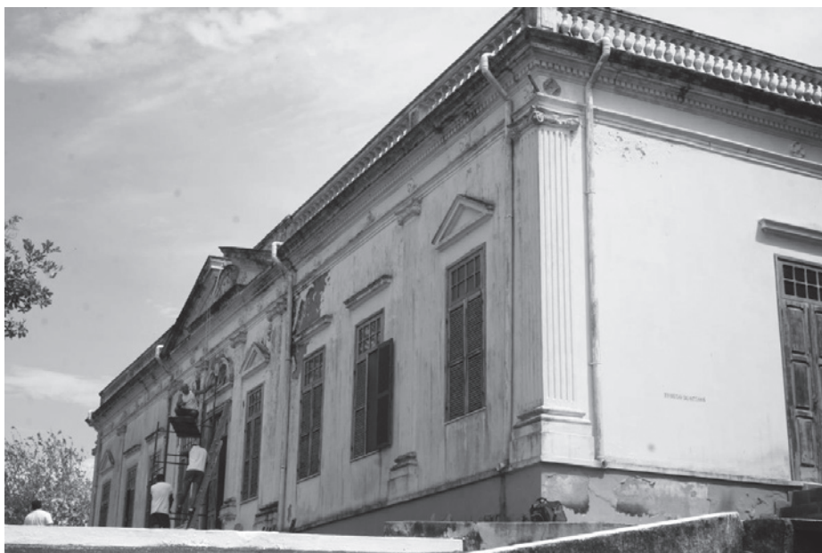
Imagem 6 – Vista do Palacete da Ilha do Rijo durante obras de recuperação em 2011. Foto: Ricardo Guimarães
