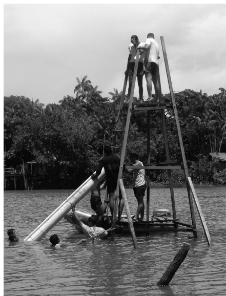
Figura 8 – Instalação de uma das estações maregráficas pelo NHi Sirius , nas proximidades da Ilha do Curuá, na Comissão Barra Norte de 2006. Apesar dos avanços da tecnologia associada à Hidrografia, os desafios nos trabalhos de campo persistiam.
