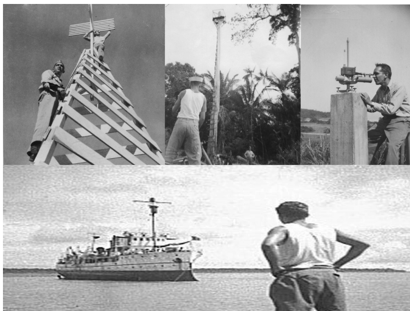
Figura 3 – Imagens da "Epopeia da Barra Norte de 1952": a instalação das torres geodésicas, a derrubada das matas para a triangulação dos vértices geodésicos e as visadas com teodolito para a poligonal topográfica. Abaixo, um tripulante observa o Navio Hidrográfico Rio Branco fundeado no Rio Amazonas
