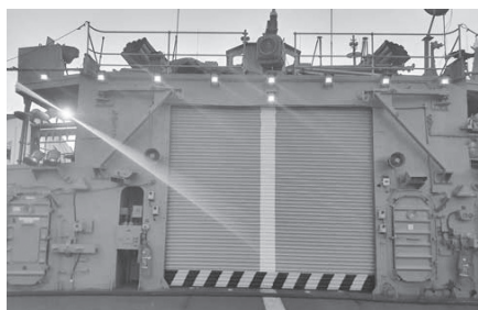
Glide Path Indicator acima da porta do hangar
