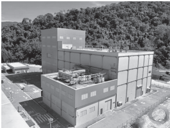
Figura 19 – Edifícios 2340 e 2380 do CMS-SUB (DEFESANET, 2021)
