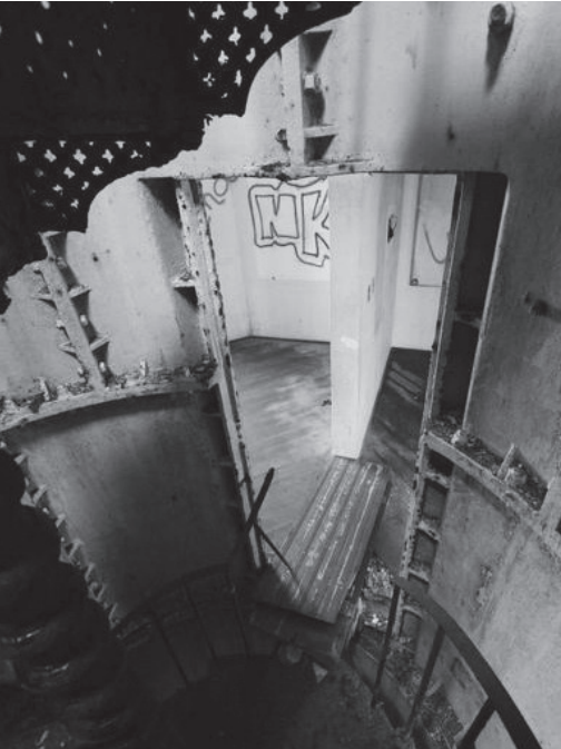
Vistas internas da torre metálica no interior da construção octogonal
