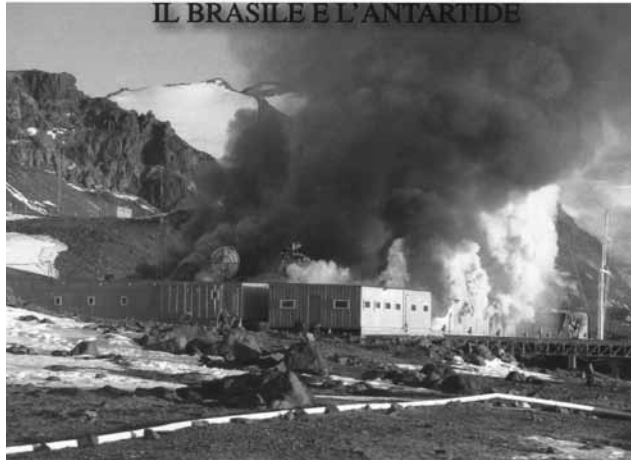
Incêndio que devastou a EACF em fevereiro de 2012
