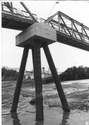
As três fotos mostram a ponte em que a variação do nível do rio é superior a 8 metros
