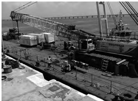
Chegada dos geradores no CIAW
