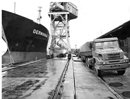
NM Germania atracado no Arsenal de Marinha do Rio de Janeiro para retirada dos escombros
